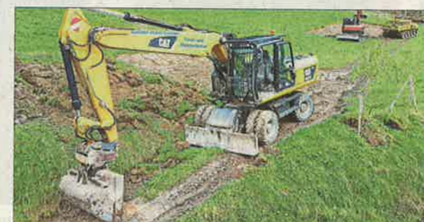
Statt der bestehende Grasnarbe soll mit kiesigem Substrat eine geeignete Aussaatfläche geschaffen werden. – F: Berghotel Rehlegg
